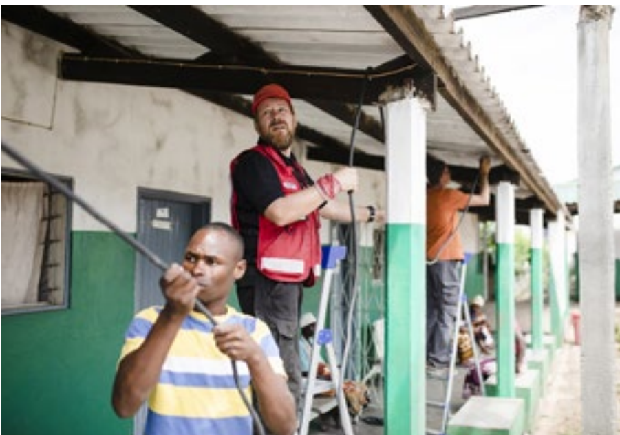
Teknikko Janne Mäkisalo, punaisessa liivissä, rakentamassa pysyvämpää sähköjärjestelmää paikalliseen terveyskeskukseen jonka tiloissa Punainen Ristikin väliaikaisesti toimii.
